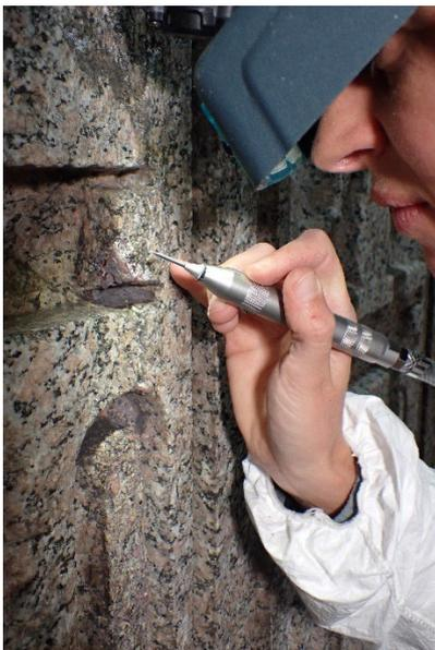
Für die Restaurierung der Fassadenoberfläche wurden die Steinverfestiger KSE 300 E und KSE 500 E von Remmers verwendet.
